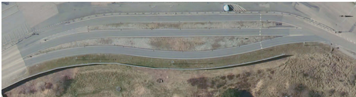
Figur 2: Eksisterende forhold ved udkørsel fra havneområdet.
